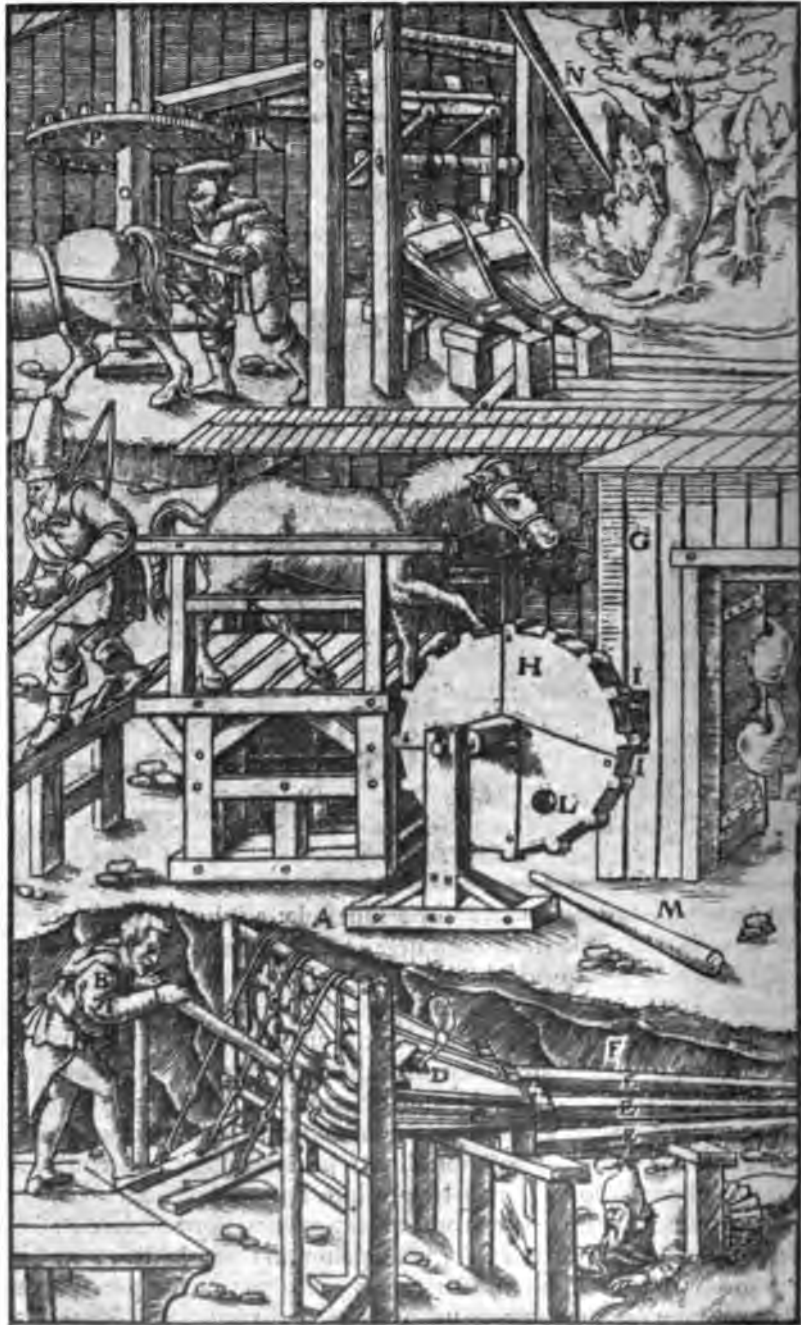
Abb. 69. Drei Antriebsvorrichtungen im Bergbau. 1556.
