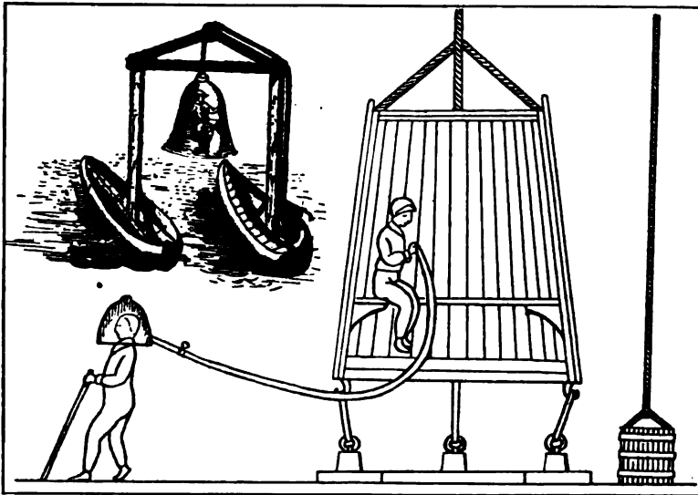
Abb. 147. Taucherglocken. Links oben nach Valentinus, 1714. Die andere Darstellung nach Halley, 1716.
