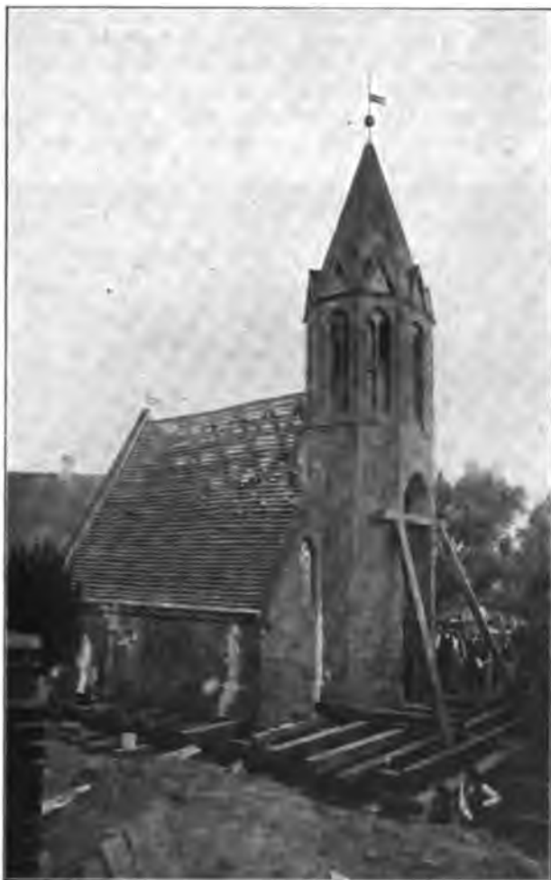
Abb. 29. Die Verschiebung der Jakobskapelle in Brandenburg a. d. Havel im Jahre 1892.
