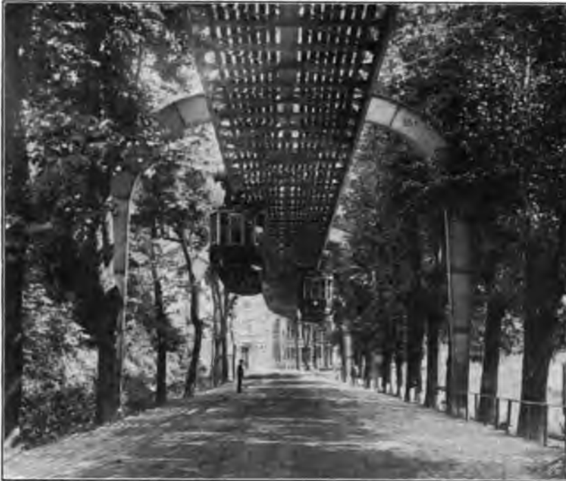
Abb. 206. Schwebebahn in Barmen-Elberfeld.
