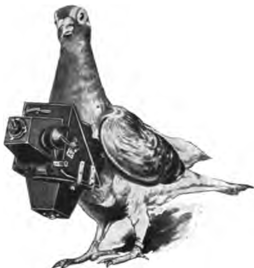
Abb. 215. Briefftaube mit photographischem Apparat.
