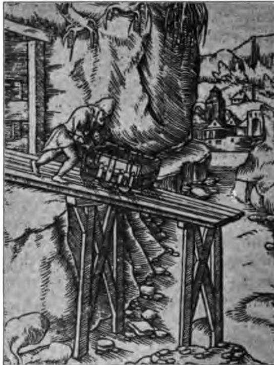
Abb. 198. Deutsche Holzbahn im Bergbau, 1556.
